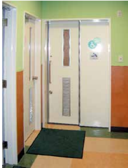
※写真は2連式外付タイプ オプション:長窓(カスミアクリル)、長ガラリ、表示錠
